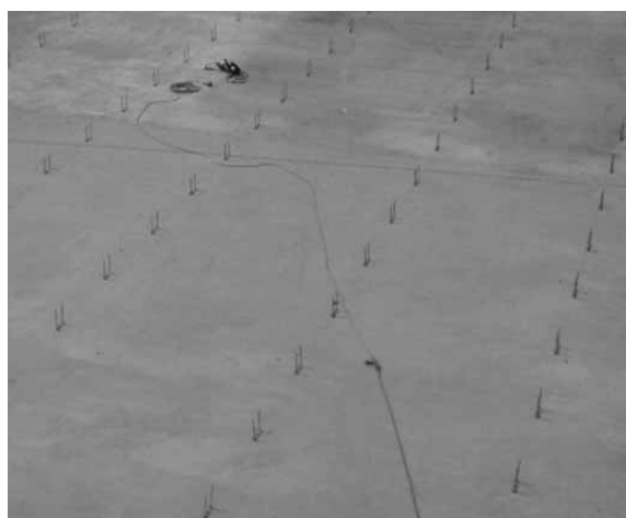
Фиг. 6 Опори на тръбите
