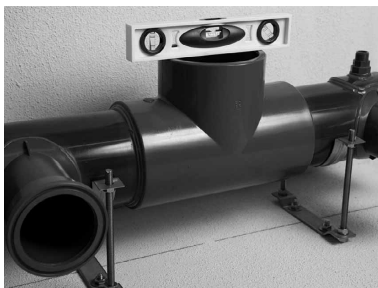
Фиг. 5 Нивелиране на колектора
