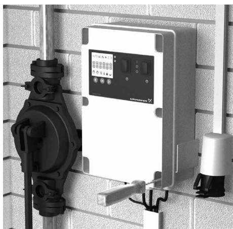
Фиг. 8 Монтаж на контролера LC 221
